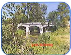
Pont de Bernay Sommières du Clain
